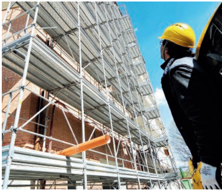
Un cantiere IMMAGINE DI REPERTORIO
