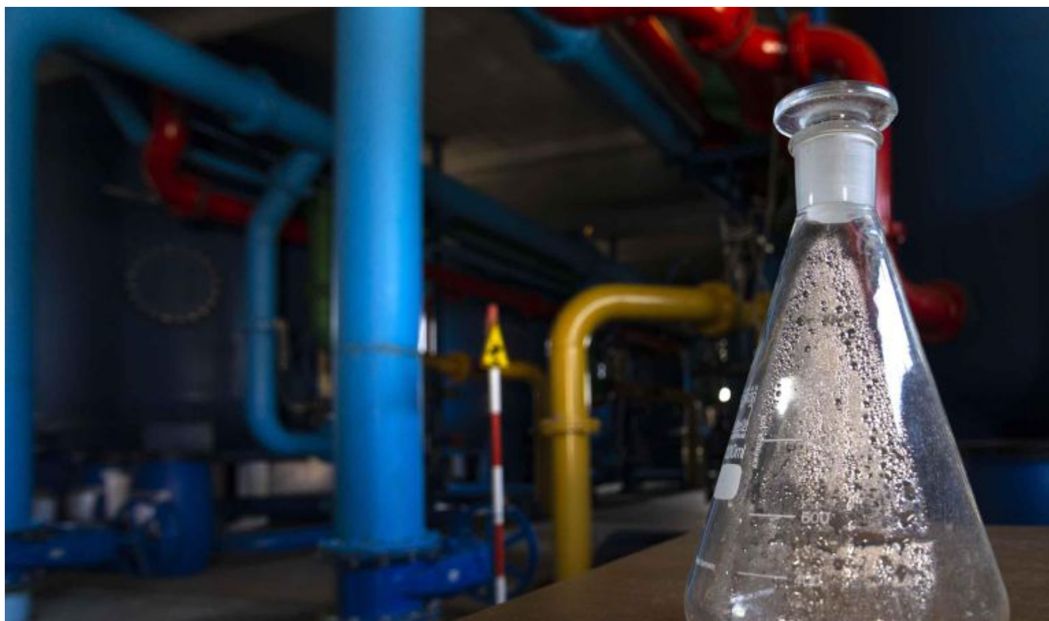
Interno della Centrale Raggera. L'impianto di potabilizzazione, con una portata di 200 l/s, alimenta la zona nord di Rimini. Qui l'acqua arriva dai pozzi della zona Orsoletto per poi essere trattata e immessa direttamente nella rete idrica
